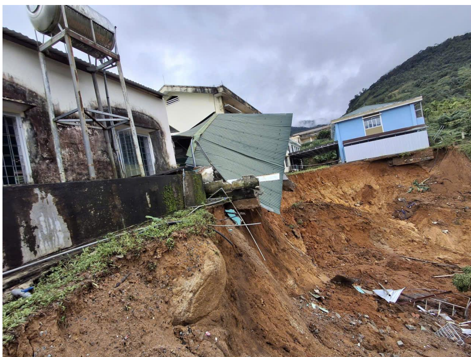
(Hình 1.2 Hiện trạng sạt lở tại Trường PTDTBT TH&THCS Sơn Long)
